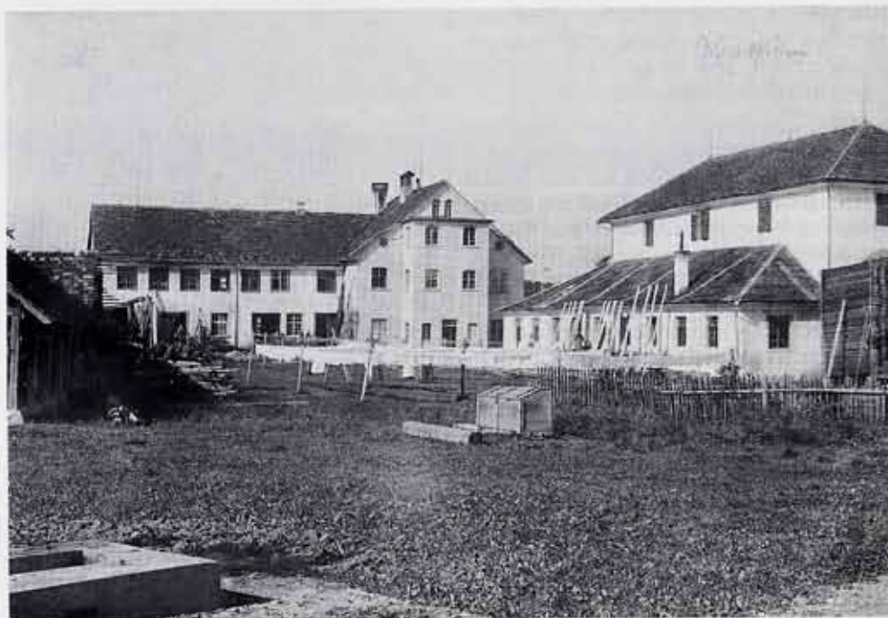
Die alten Fabriksgebäude wurden vom Kloster als Werkstätten verwendet: Rechts im Bild die alte Sägerei und Schreinerei, links dahinter Waschküche, Schmiede und Wagnerei samt Personalwohnungen
