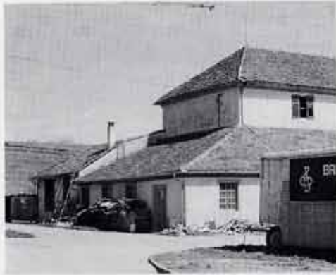
Die Sägerei/Schreinerei kurz vor dem Umbau zur Heizzentrale
